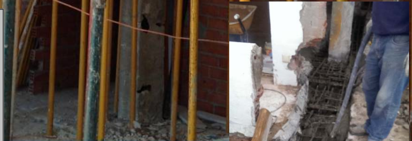
hormigonado de la viga (vista superior)
